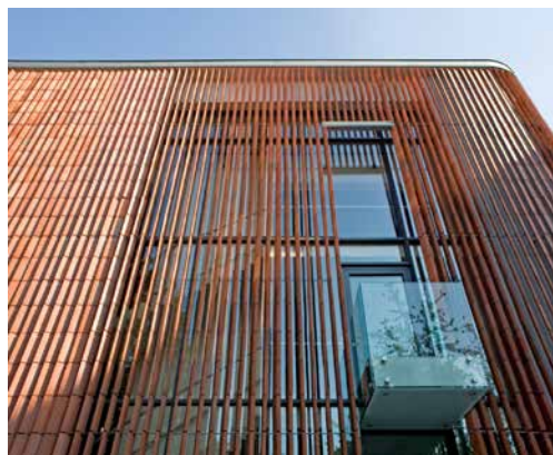
Fot. 14.15. żaluzje zbudowane z koralików ceglanych, własność Ingarden&Ewý Architekci
