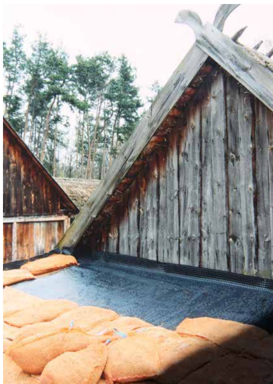
Ryc. 5 Worki siatkowe wypełnione trociną jako jeden z etapów konstrukcji dachowej Fot. Jerzy Wojtatowicz.
