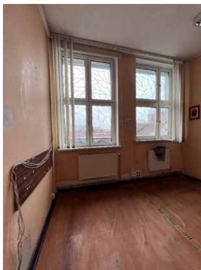
Fot. 9 Pomieszczenie nieużytkowe w liceum
